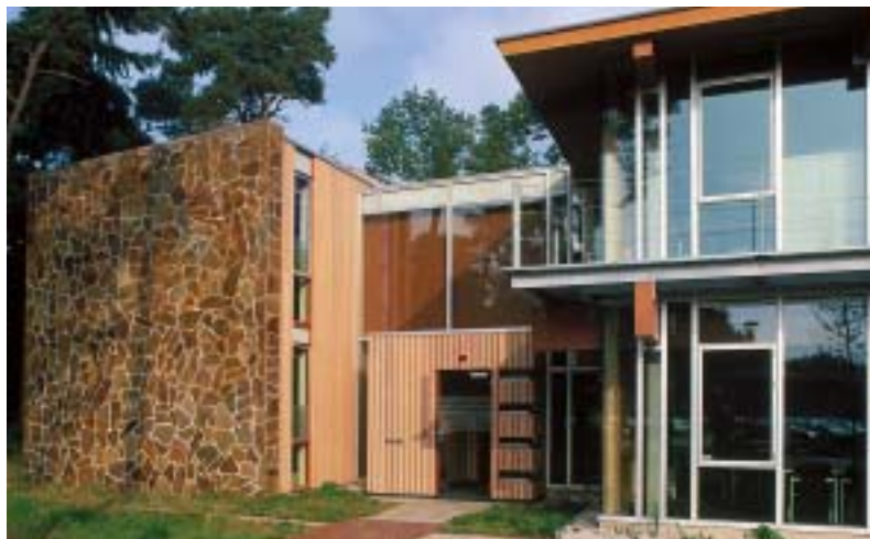
Entree met lariks wand die zich buiten voortzet, en bijpassende balie. De loopbrug verradt een verschil in verdiepingshoogte.
